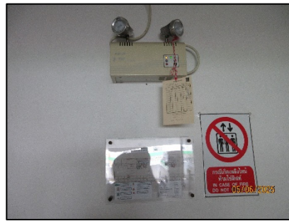
รูปที่ 13 ไฟฟ้าสำรองของโครงการ
